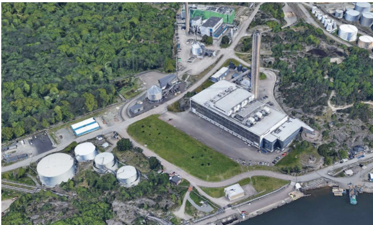
Figur 4 Översikt befintlig anläggning, (Google Earth)
